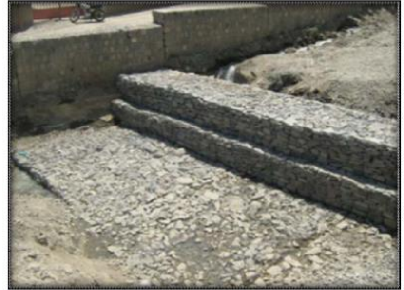
شکل ۱-۱- نمونه‌ای از کفبند توری سنگی در کنار دیواره سنگی [۱۳]
